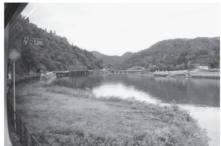
豪雨災害で被災した区間。写真左奥に写る第8只見川橋梁（トラス桁）は、三信鉄道（現・J R飯田線）中部天竜駅～佐久間駅の間にあった天竜川橋梁からの転用品とされる
