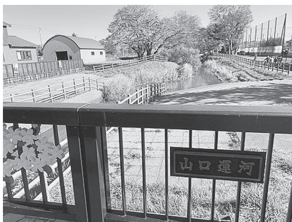
山口運河（星置2号橋付近）
