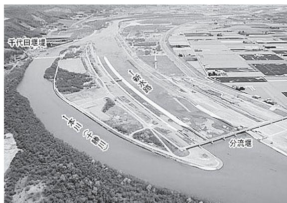
左側が本流で中州を挟んで右側が千代田新水路。手前に分流堰がある。新水路と中州の間に全長1300m、幅30mの世界最大級の実験水路があり、疑似洪水を発生させる実験などが行われている＝帯広開発建設部ホームページより
