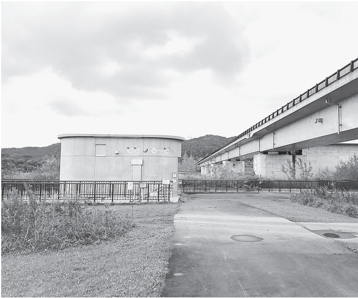
千代田新水路に架かる橋は中州まで。中州の下流側から対岸の池田町の道道73号に出られるが、一般車両は通航できない。写真左の建物が「魚道観察室ととろーど」で、秋には魚道を遡上するサケなどを見ることができる
