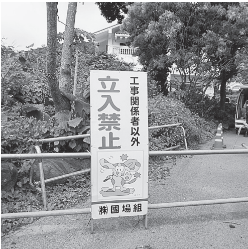
工事が進む元「ジュマール・ゴルフガーデン」前 (2020年2月25日撮影)
