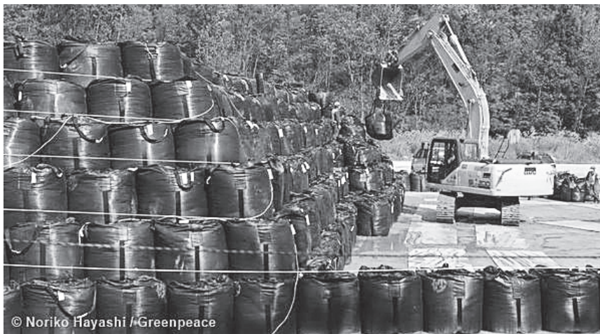
除染によって生命の大切な土壌が剥ぎ取られ積み上げられる
