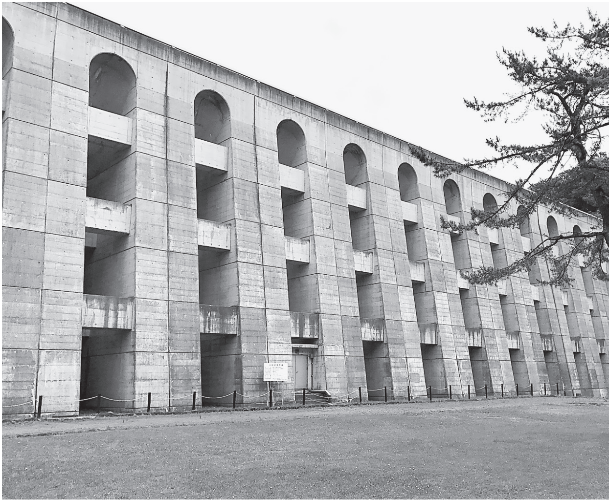
日本土木学会の「選奨土木遺産」である笹流ダム。日本で最初に建造された貴重なバットレス型ダムで、函館市民の飲料水を供給している。日本ではこれまでに10基造られ、6基が現存し北海道では唯一のダムである
