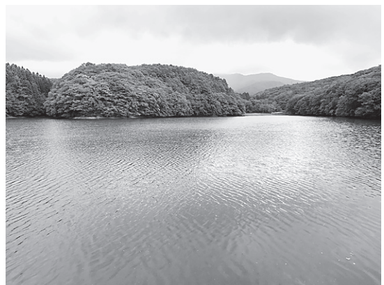
笹流ダムの上の歩道から眺める「笹流貯水池」は、意外なほど水面が近い。四季折々清々しさをたたえている
