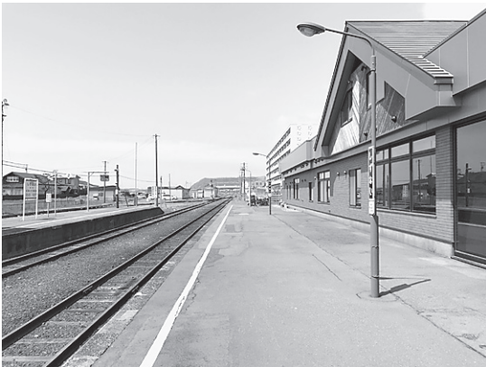
2015年の高波被害で線路の土砂が流出し、日高線は鶴川一様似間が運行不能になったまま放置されている。静内駅の線路は真っ赤にさび付いていた
