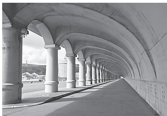
ドームの回廊は427メートルもある。冬季の風波を受け止め、乗降客や列車、貨物などを守る頼もしい防波堤だったことがよく分かる
