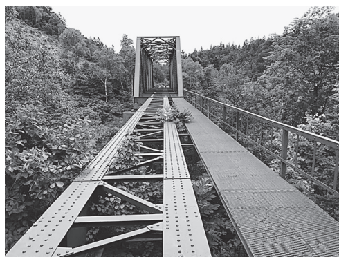
深名線「第3雨竜川橋梁」。雨竜川上流の「ボン・カムイコタン」渓谷に架けられた鉄橋。2009年に土木学会選奨土木遺産に認定されている
