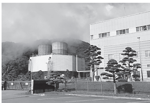
地熱発電の北海道電力森発電所 こつ音を上げて水蒸気を噴出する
