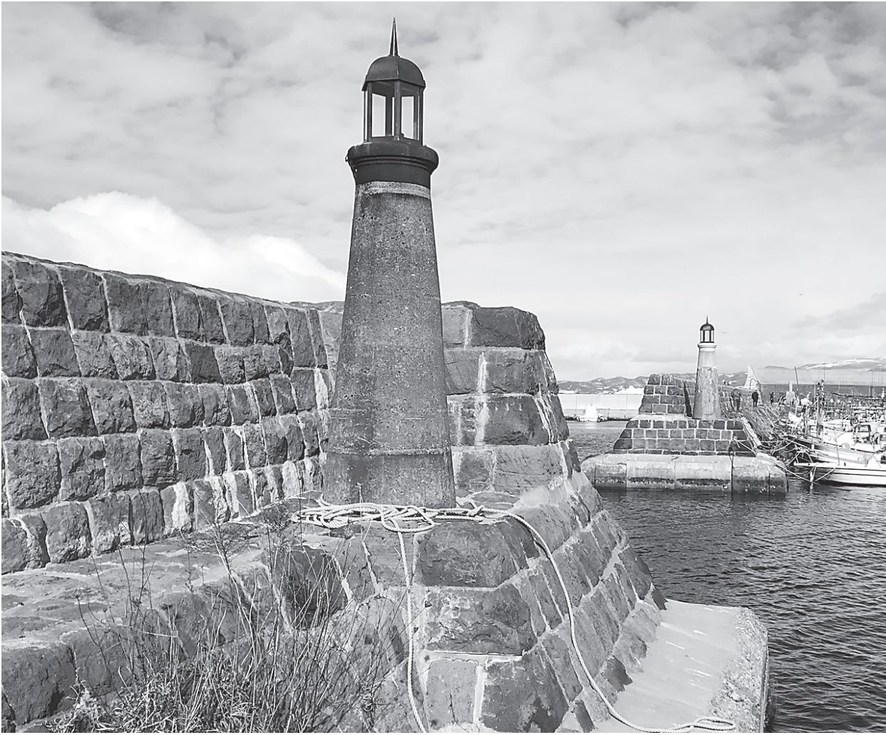
1899（明治32）年に完成した「函館漁港船入澗（ふないりま）防波堤」は土木学会選奨土木遺産で、江戸幕府が外国船の襲来に備えて造った砲台「弁天台場」の石垣の石材が再利用されている。
