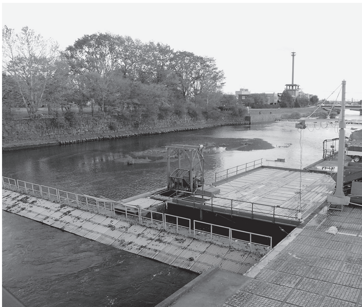
インディアン水車橋の手前、川幅いっぱいに設置されているのがウライというサケを水車に導く仕掛け
