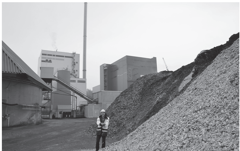
木質バイオマスを使ってベクショーの暖房と電力をまかなっているコージェネレーション施設。周囲にはチップがうずたかく積まれている（筆者撮影）
