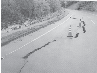
一般国道44号厚岸町神尾幌
