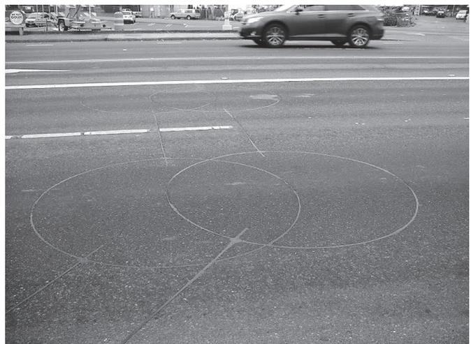
車を感知し信号を操作するアンテナが埋め込まれた道路
